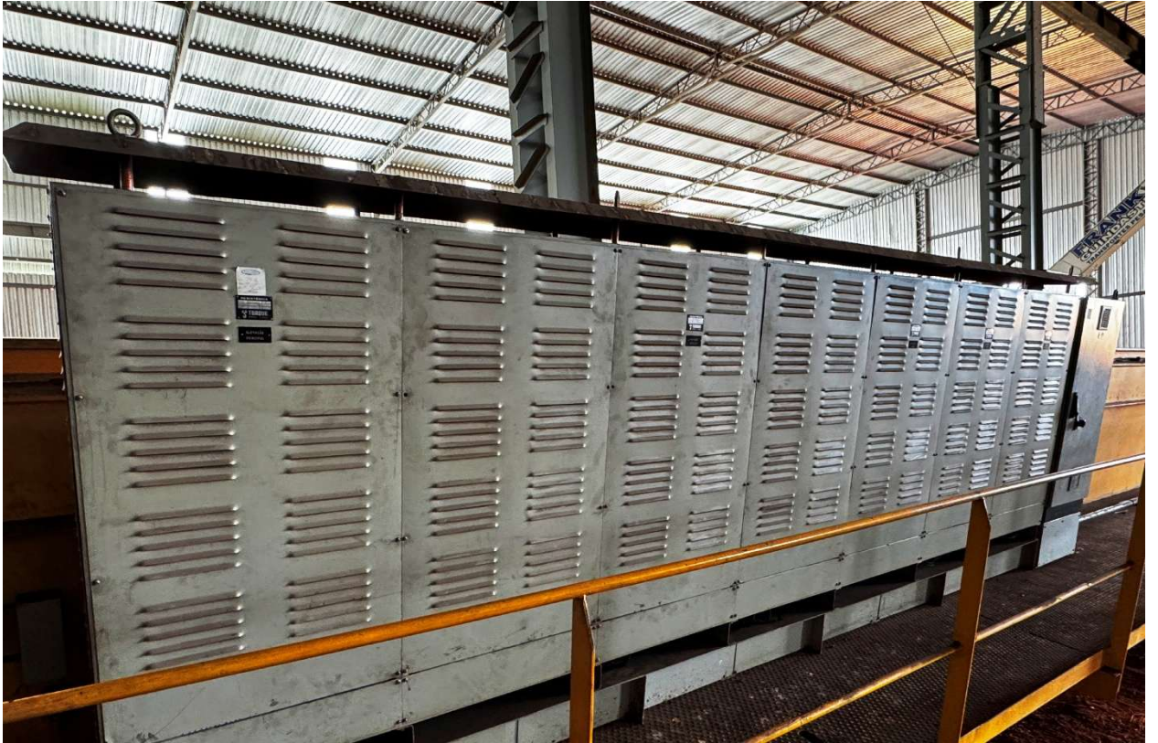
Banco de Resistores para frenagem dinâmica
